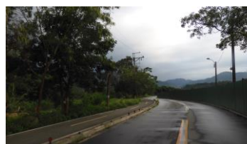
二標計畫區狀況(2023.06.07)
