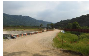
橋梁標計畫區狀況(2023.06.07)
