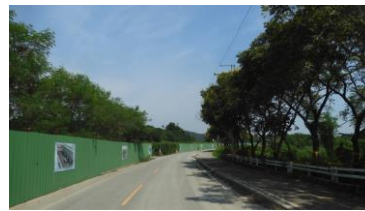
二標計畫區狀況(2023.09.13)
