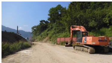
橋梁標計畫區狀況(2023.09.13)
