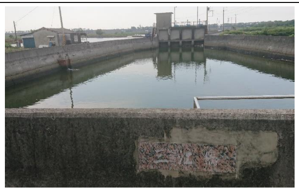
水岸及護坡照片
