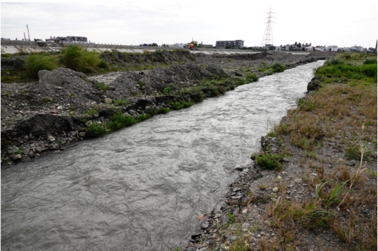
圖 5-5 太平溪左岸工程設置導水土堤束縮河道情形
