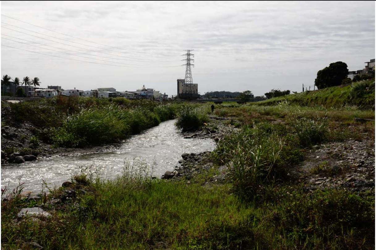
說明：2 區現場情況
