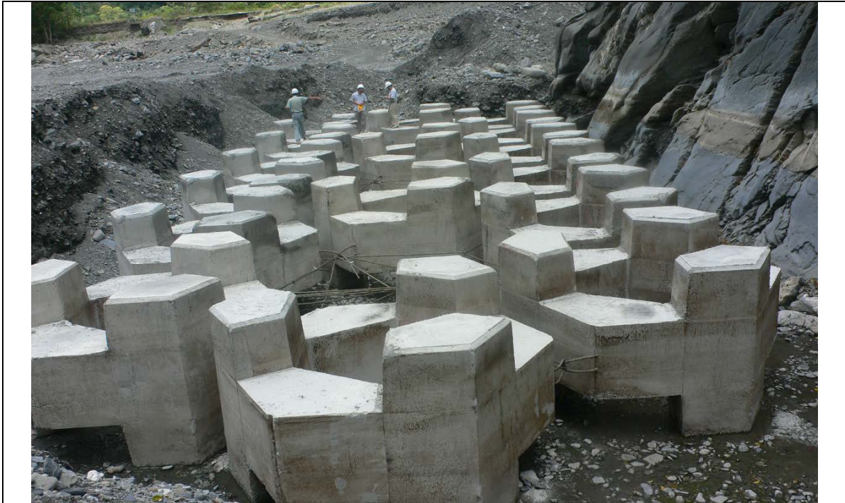
說明：基礎保護工施工情況
