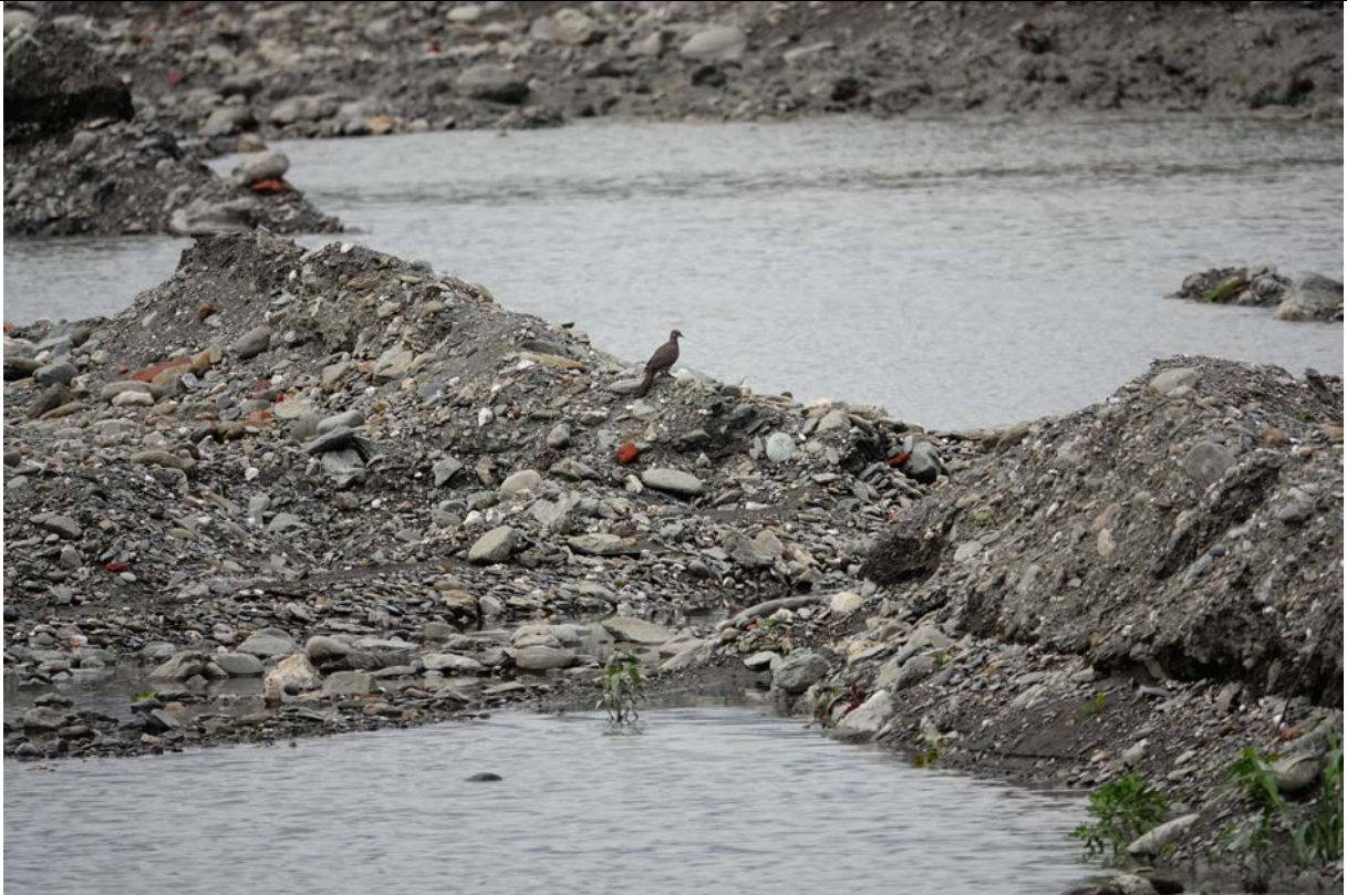
說明： 5 區現場情況
