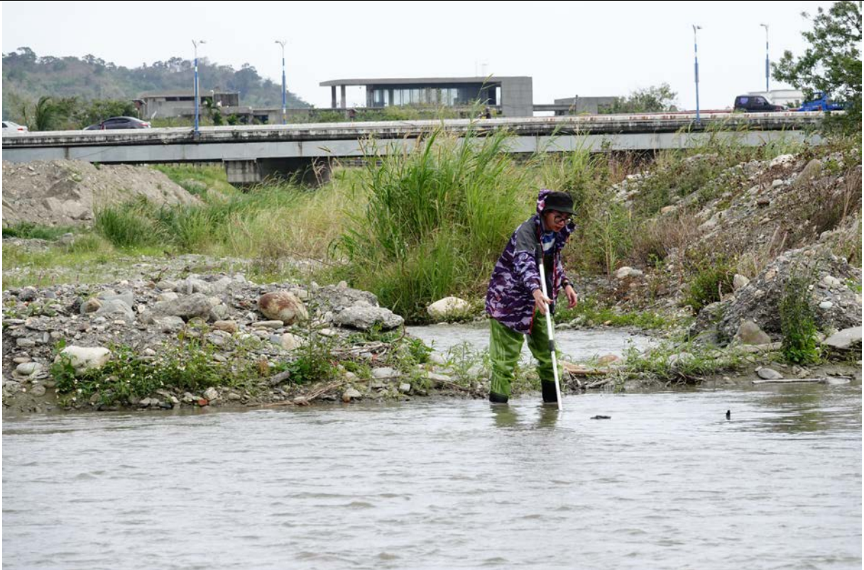
說明：3 區現場情況
