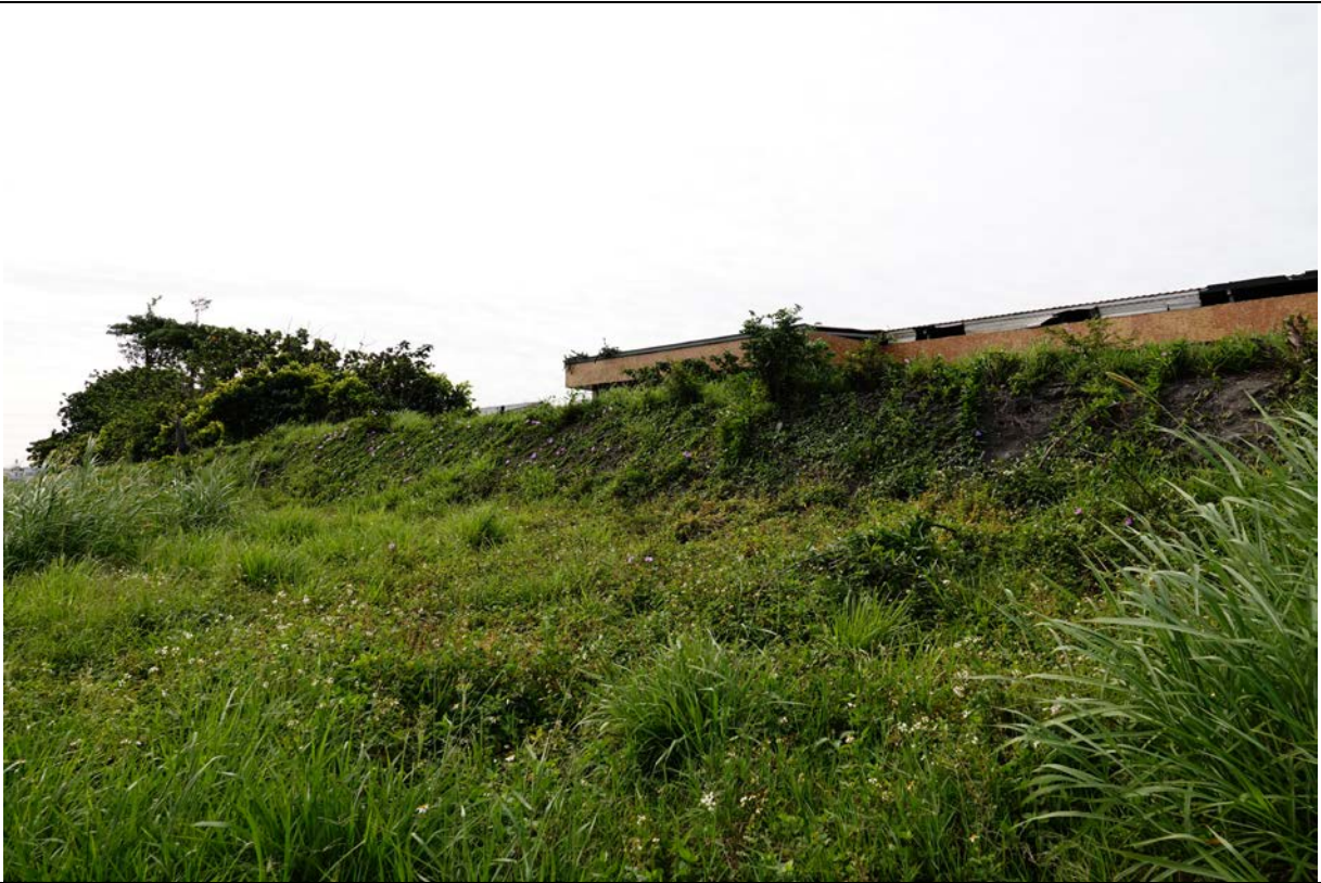
說明：1 區現場情況
