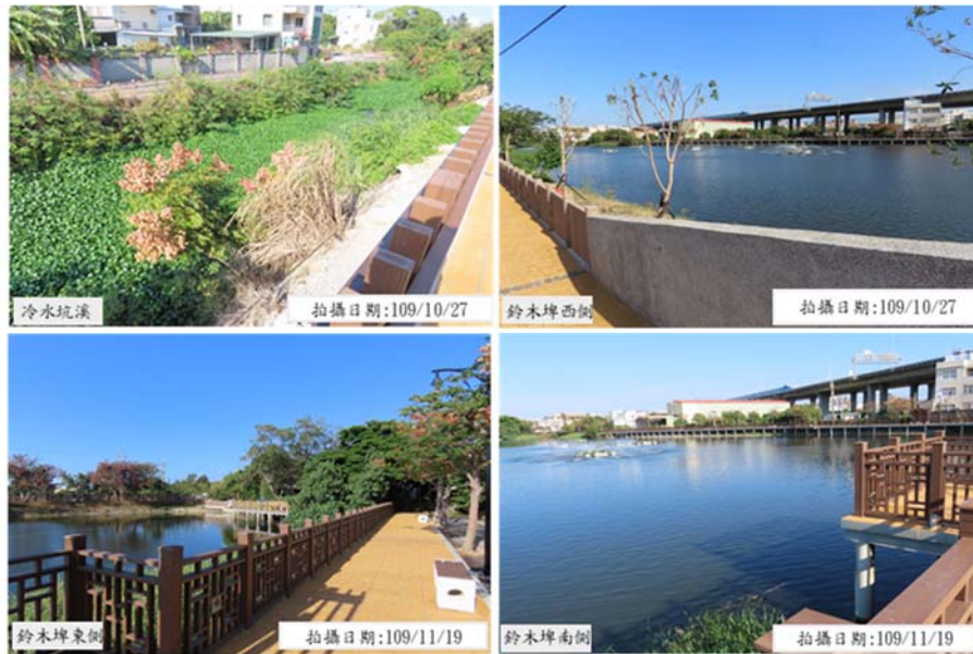
圖 7-9 「竹南鈴木埤親水環境工程改善計畫」現地勘查照
