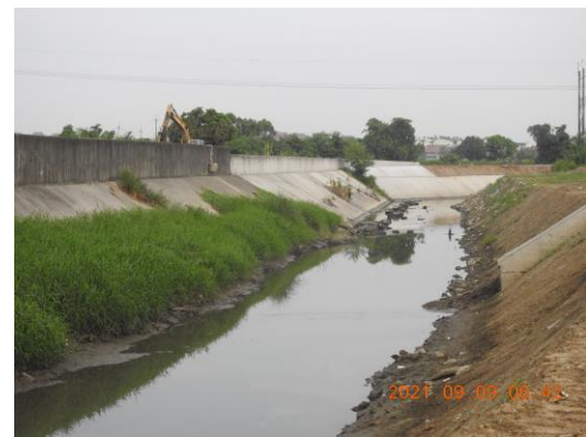
前案施工現況 (拍攝時間 110.9.8)
