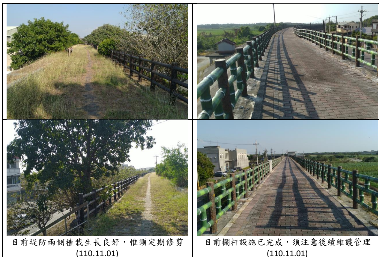
圖 4-6 北港溪環境改善工程生態保育措施執行後現況
