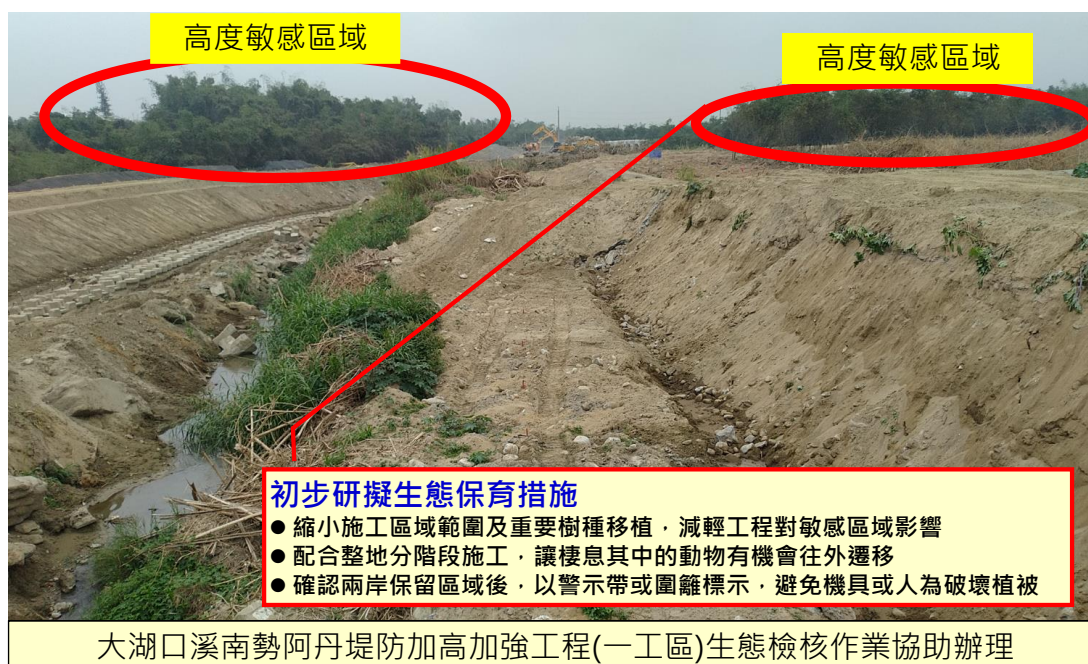
圖 4-3 南勢阿丹堤防加高加強工程施工中生態檢核狀況說明圖
