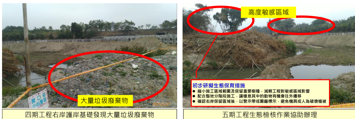
圖 4-2 林子舊社堤防防災減災工程施工中生態檢核狀況說明圖
