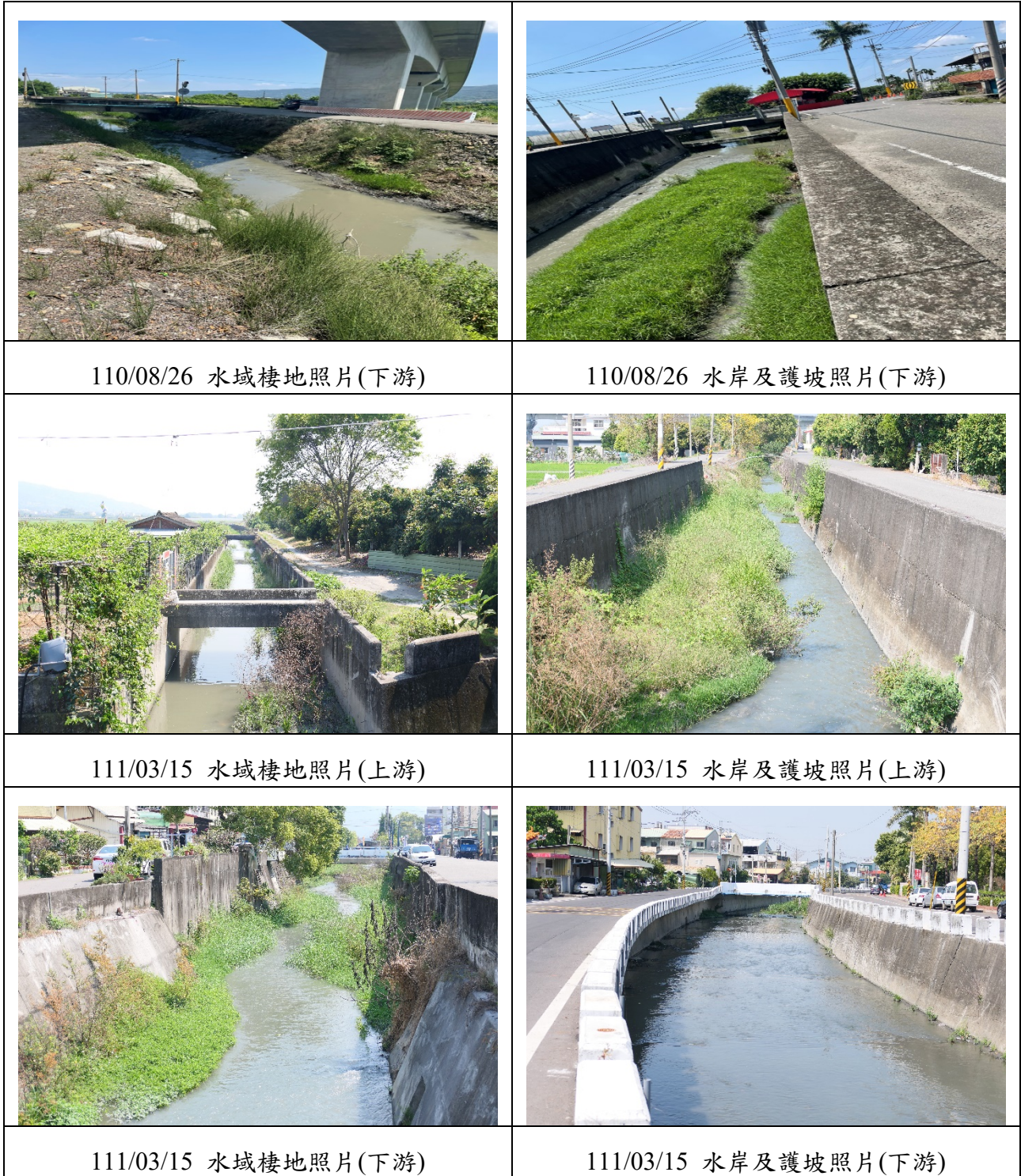
圖 55 舊社排水(第二期)改善及橋梁改建工程併辦土石標售 (1k+194~3k+147) 環境現況照片(施工階段)
