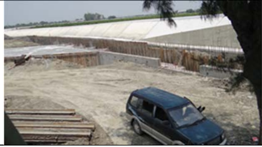
水岸及護坡照片
