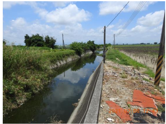
樹林橋上游區段 ( 拍攝日期 110.07.08 )
