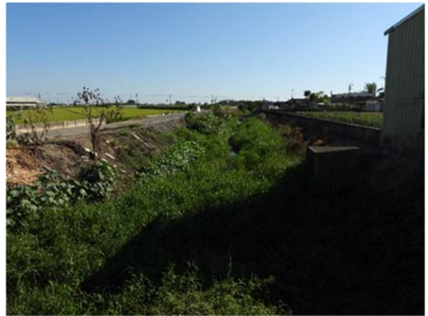
水岸及護坡照片
