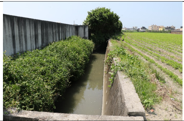
110/08/26 水岸及護坡照片(上游)
