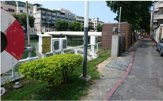
鎮東一街抽水站
