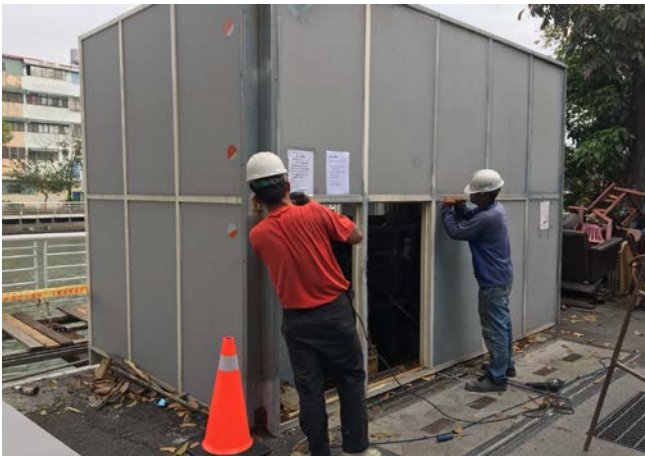
鎮東一街抽水站
