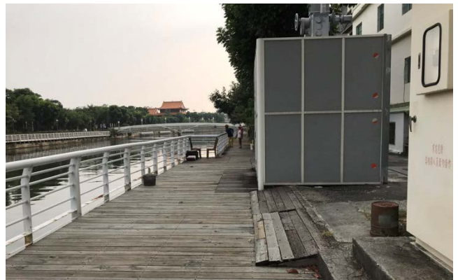
鎮東三街抽水站
