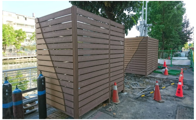
鎮東三街抽水站
