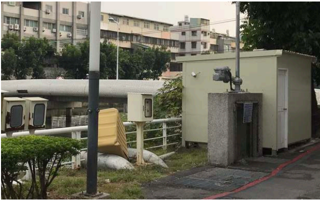
鎮東一街抽水站
