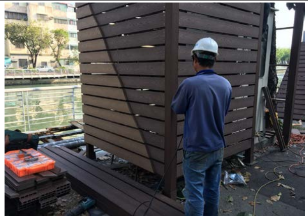
鎮東三街抽水站
