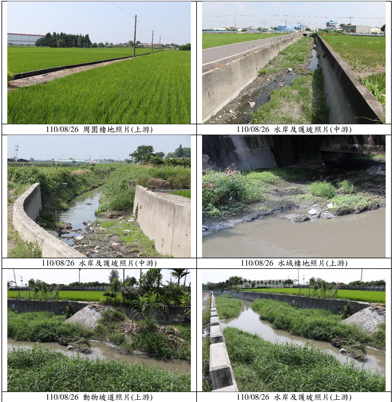
圖 16 公館排水(第一期)改善工程環境現況照片(提報階段)
