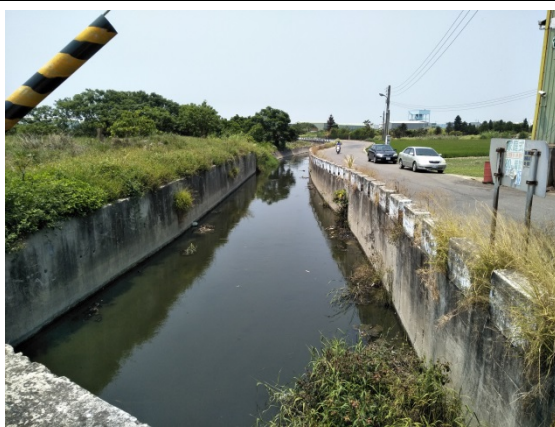
說明：垂直混凝土護岸
