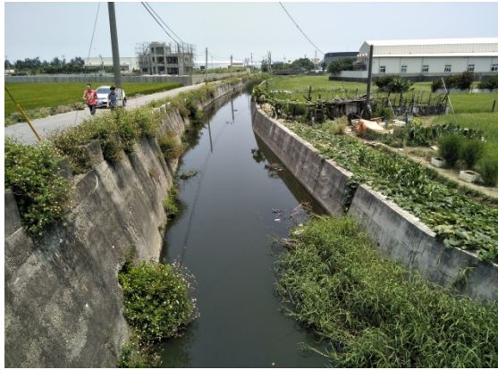
說明：排水路現況景觀
