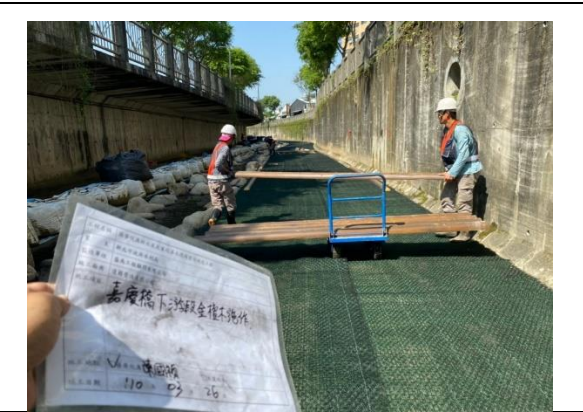
遵照生態團隊建議以小型機具及手作方式施工，降低破壞面積。
