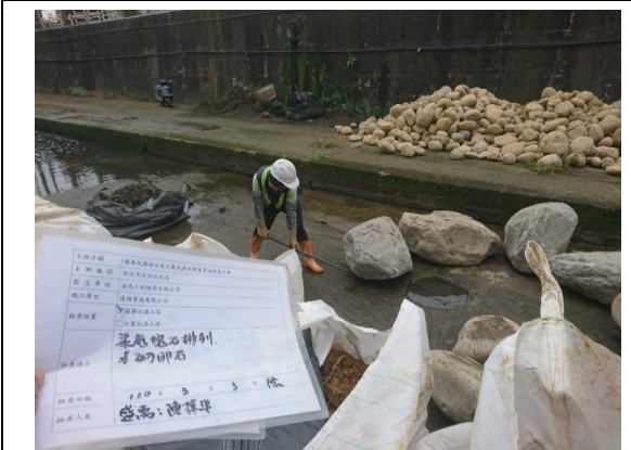
遵照生態團隊建議以小型機具及手作方式施工，降低破壞面積。
