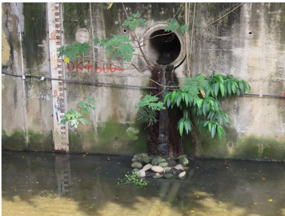
圖為生長於渠道內的構樹及榕樹，長大後根部易造成結構危害。
