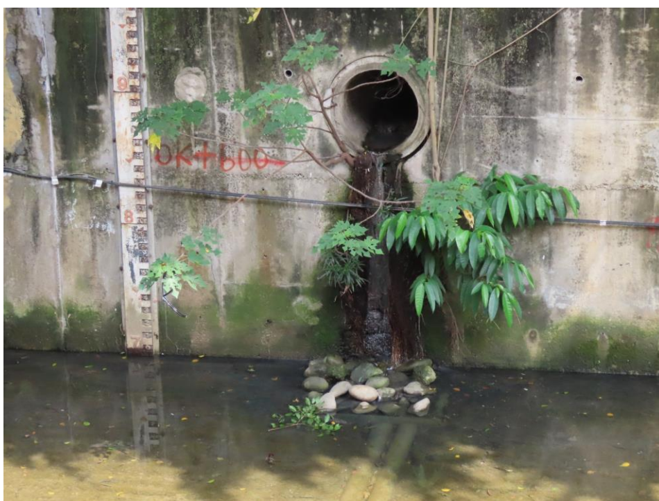
圖為生長於渠道內的構樹及榕樹，長大後根部易造成結構危害。
