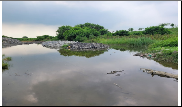
日期：2022/7/25施工廠商拍攝 說明：暫置區原置放AC刨除廢料已完成運離，現地置放之塊石為它案堆置，非屬本工程之範圍
