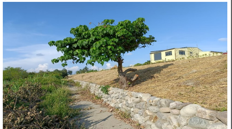
日期：2022/6/25施工廠商拍攝 說明：填土覆蓋血桐四周，外圍砌築塊石，排水功能良善
