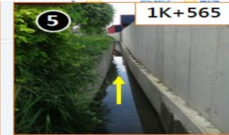
柑仔井二號支線小給1
