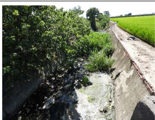
水岸及護坡照片
