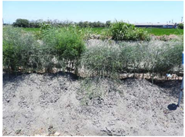
水岸及護坡照片
