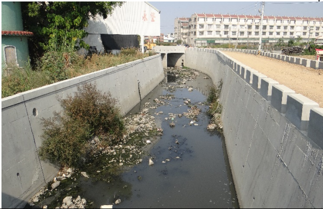
110/08/26 水岸及護坡照片(上游)
