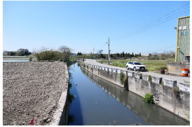
111/03/08 水岸及護坡照片(上游)
