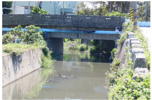
111/03/08 水岸及護坡照片(下游)
