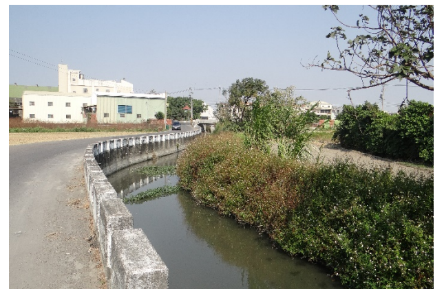
110/08/26 水岸及護坡照片(下游)
