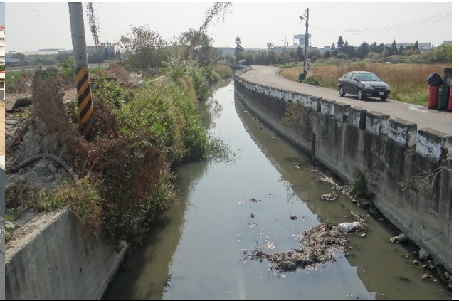
110/08/26 水岸及護坡照片(上游)
