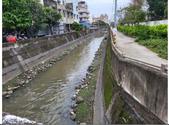
射流溝環境現況
