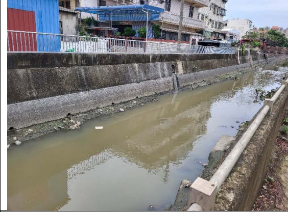
射流溝環境現況
