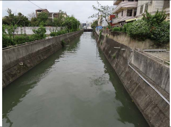
射流溝環境現況
