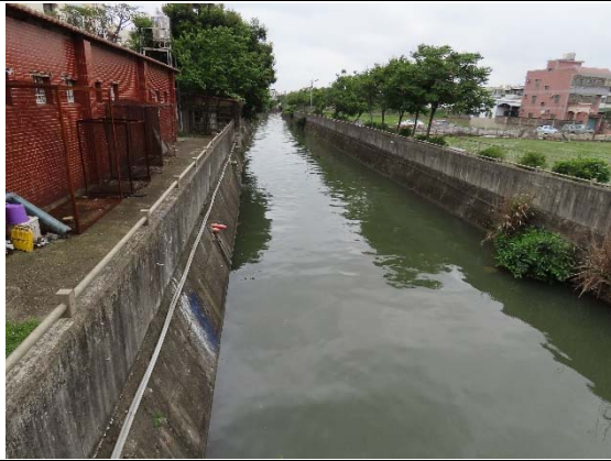
射流溝環境現況
