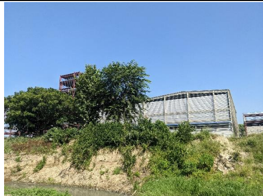
計畫周邊正在新建的建物 (拍攝時間 110.10.19)
