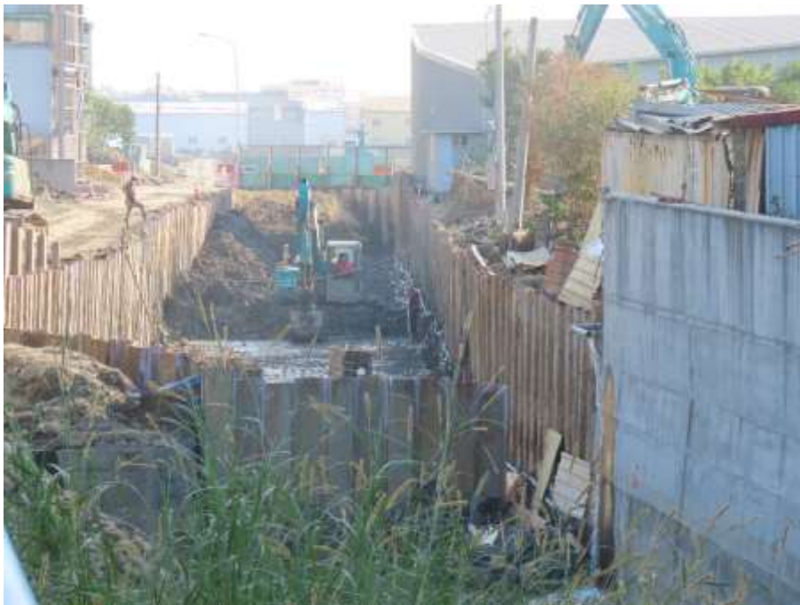
圖 5 花壇排水(第二期)上游改道工程現況圖(109.11.17 施工中)
