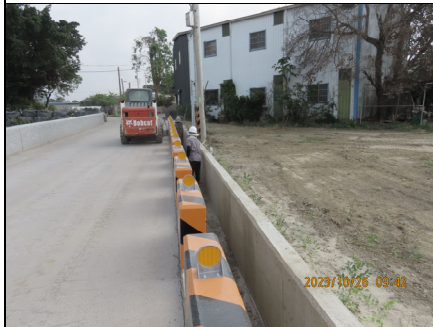
施工廠商清除側溝淤泥
