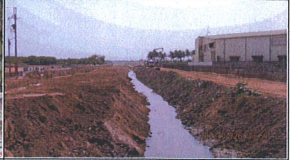
公學路至與上下段工程施工狀況
