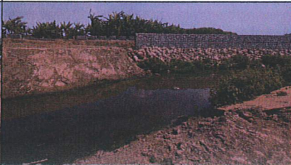
施工起點與下游段工程銜接處水域未受阻
