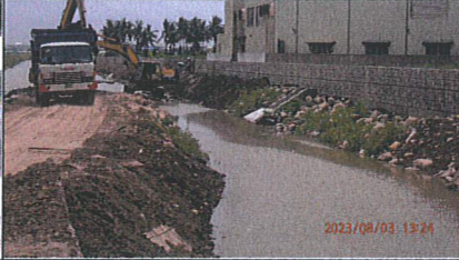
復原河道中施工便道，溪水暢通
