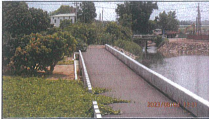
安吉路至公學路施工狀況，左岸防汛道路已鋪設 AC
