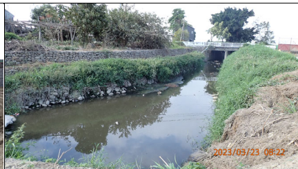
過水路往下游拍，石籠護岸區段兩岸濱溪尚未擾動
