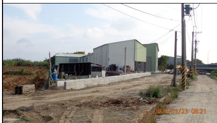
右岸側溝施工中
