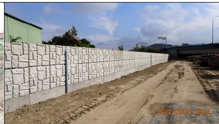
右岸防洪牆施工中
