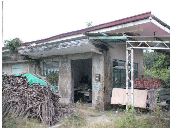
圖 5-2- 4 左鎮車站拆除前照片
