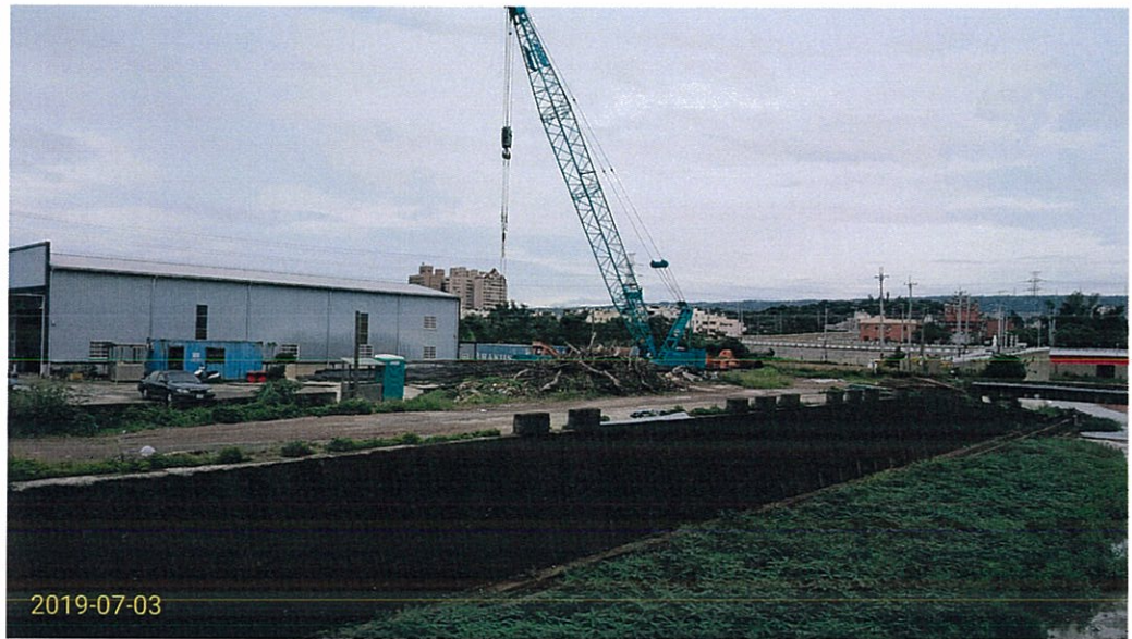
施工前照片 右(北)岸工區
