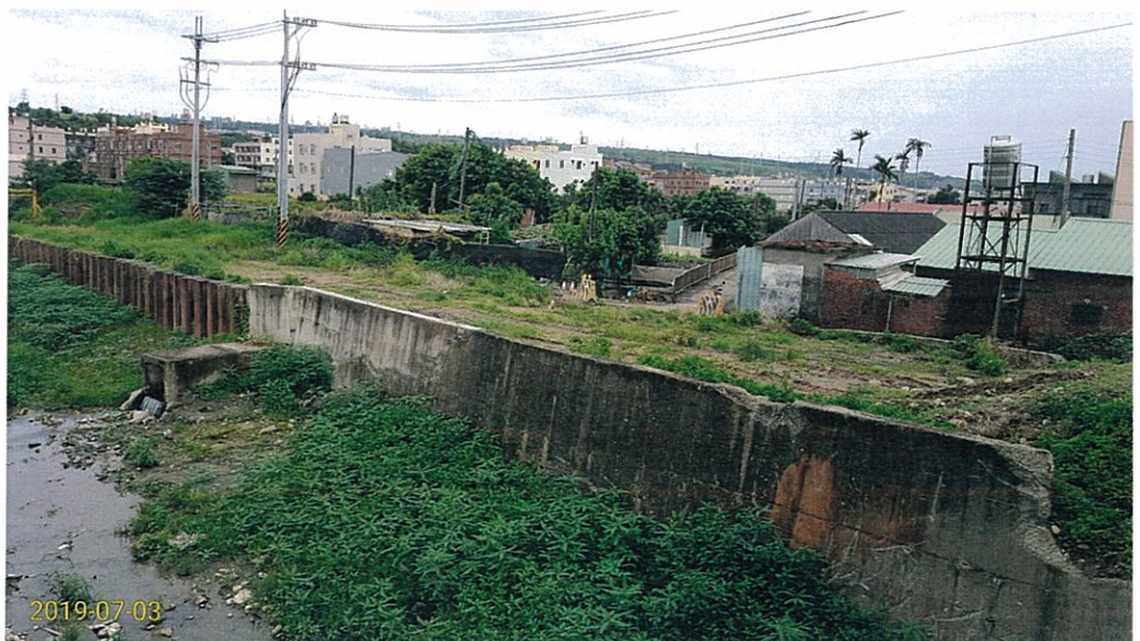
施工前照片 左(南)岸工區
