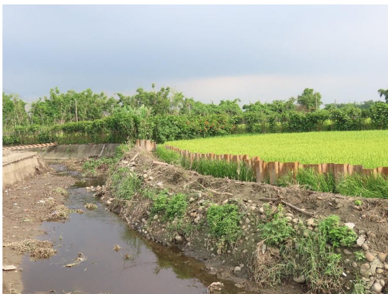
圖 4 柳子溝排水(西庄里段)應急工程環境概況圖(109/05/29)
