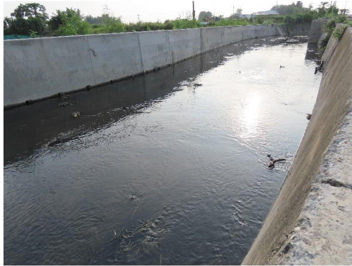
圖 6 柳子溝排水(西庄里段)應急工程環境概況圖(109/08/28)
