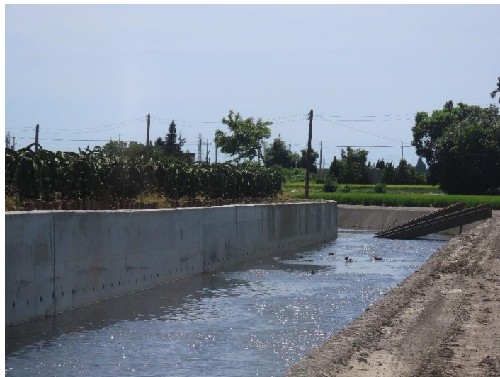
圖 5 柳子溝排水(西庄里段)應急工程環境概況圖(109/06/10)
