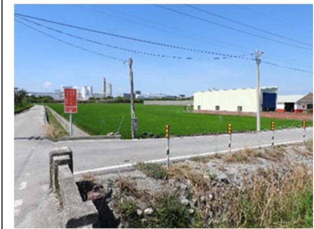
水岸及護坡照片
