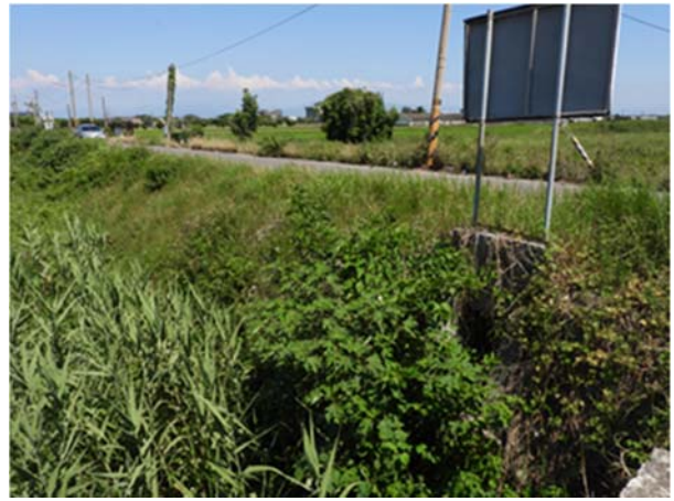
水岸及護坡照片
