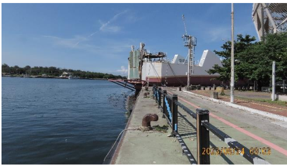
位置：120.15189, 22.99115 說明：預定工區-水域環境周邊現況。
