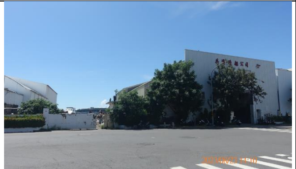
位置：120.15691, 22.99095 說明：預定工區-永華路端，為既有道路，開發程度高。
