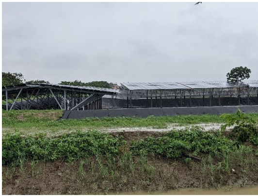
與溪墘大排交界處設有光電板 (拍攝日期 110.06.23)
