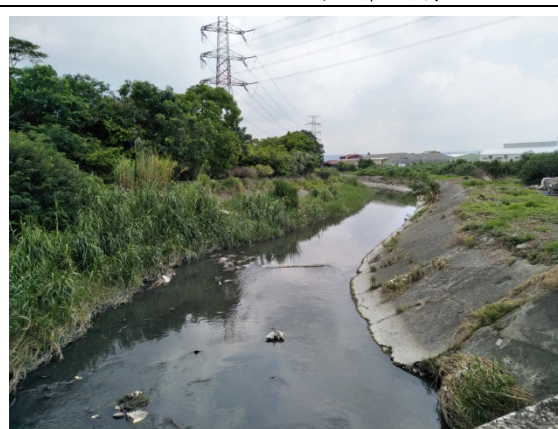
說明：混凝土斜坡護岸
