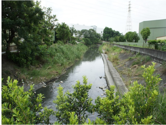
說明：混凝土斜坡護岸
