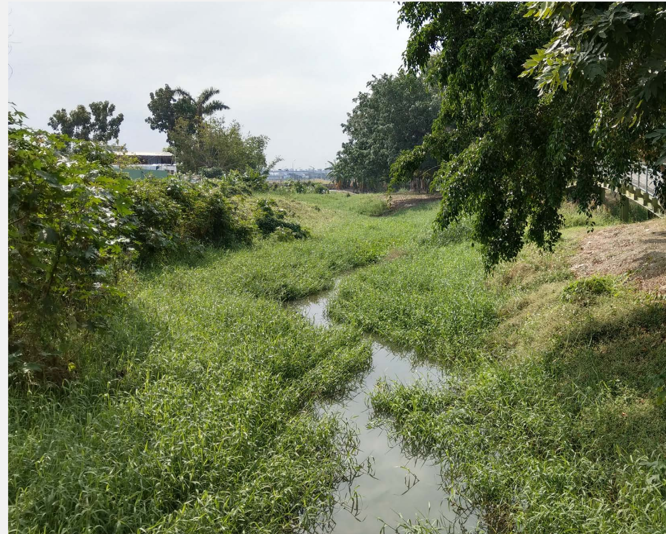
九番埤施工前現況
