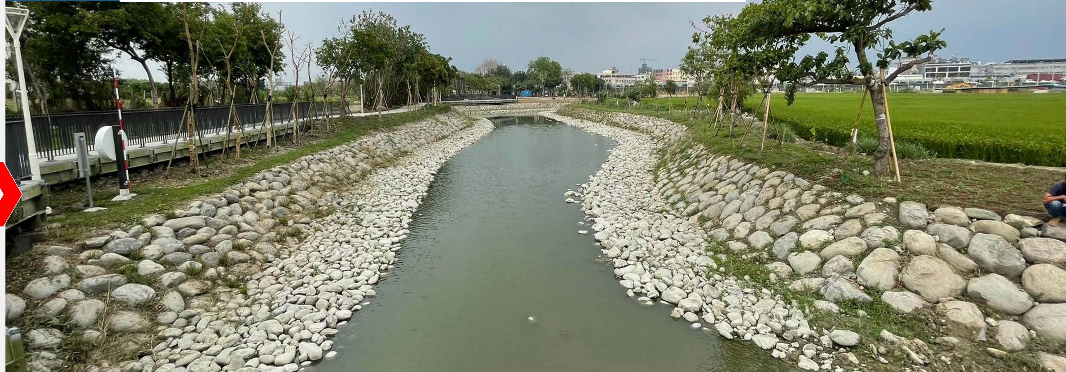
施工後 水域清淤施作塊石護岸，恢復通水斷面
