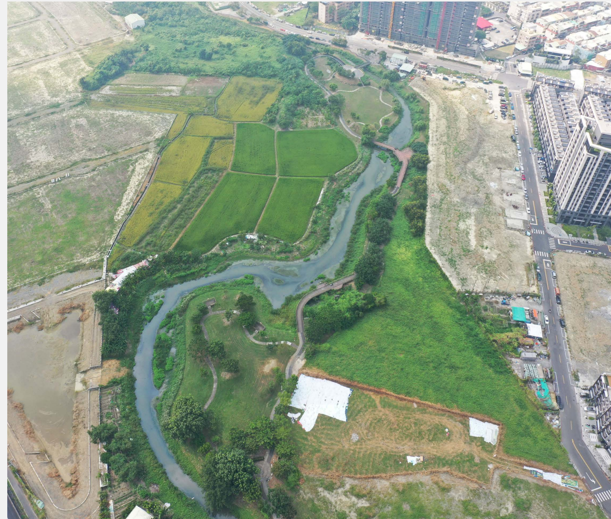
九番埤施工前現況空拍
