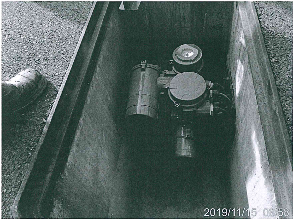
施工完工照片
