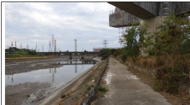
通霄橋下游右岸邊坡(110.11.03)
