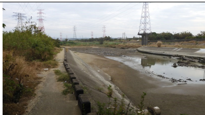
通霄橋上游右岸邊坡(110.11.03)
