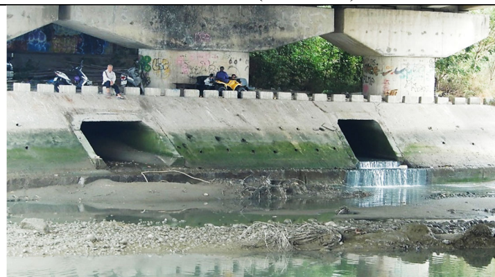
通霄橋下方排水口(110.11.03)
