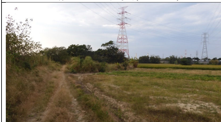
梅南橋上游右岸堤內道路(110.11.03)
