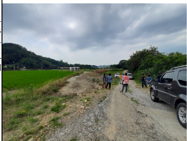
圖 5：工程保全標的為左岸之農地與道路。
