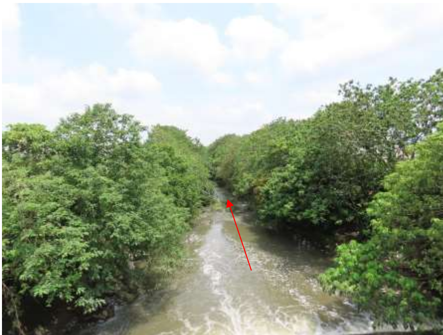
圖 4 東溝排水(第一期)改善工程之現地照片(109/05/29)
