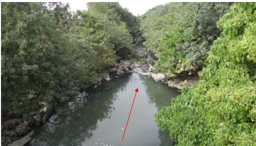
圖 3 東溝排水(第一期)改善工程之現地照片(108/11/20)
