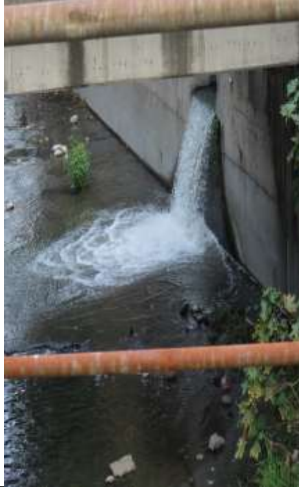
109/4/13 施工中 (濱溪帶植生保留)
