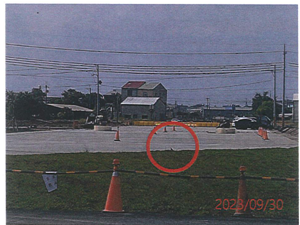
日期：112.09.30 說明：施工時應善待工區內出沒動物
