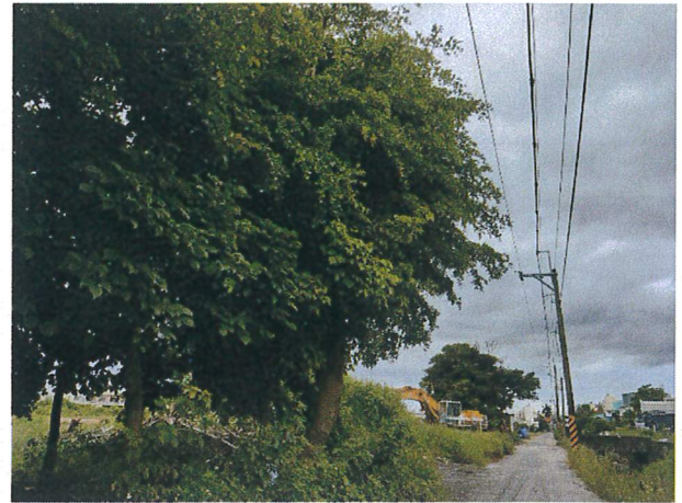
日期：111.06.29 說明：保持原地植栽並定時灑水
