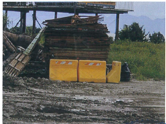
日期：111.06.29 拍攝 說明：施工便道及器材堆置區優先利用既有裸地
