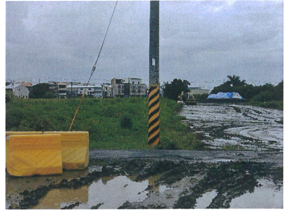
日期：111.06.28 說明：除施工道路外保留原地面植被
