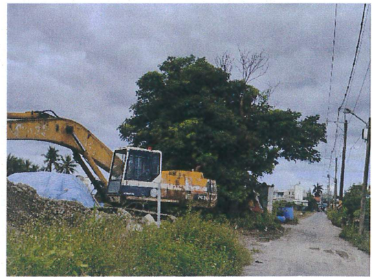
日期：111.06.29 說明：保持原地植栽並定時灑水
