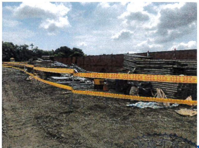
日期：111.08.30 說明：施工便道及器材堆置區優先利用既有裸地
