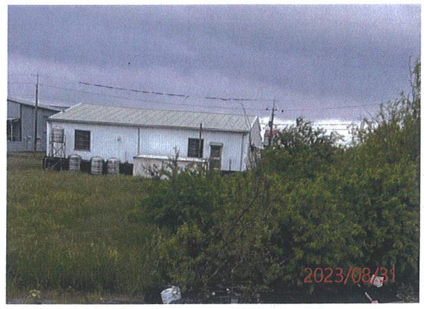
日期：112. 08. 31 說明：除施工道路外保留原地面植披
