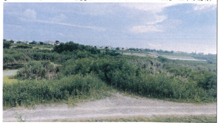
日期：2021/8/31施工廠商拍攝 說明：本區域尚未施工。
