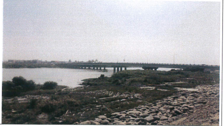
日期：2022/1/26施工廠商拍攝 說明：已施工，沒有擾動影響。
