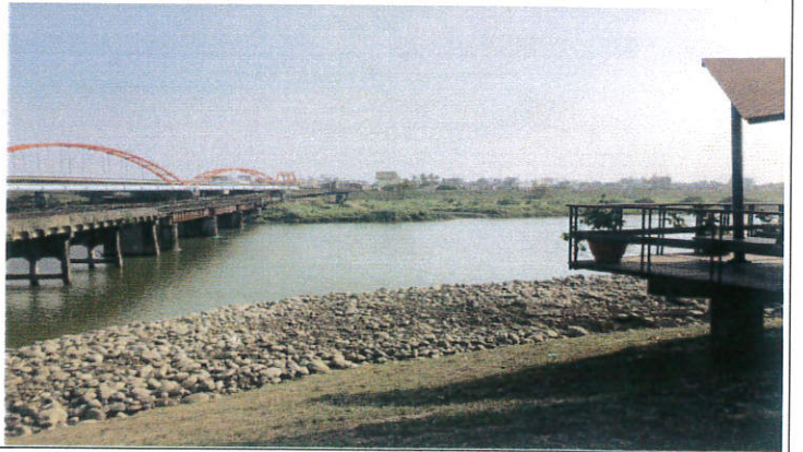
日期：2022/1/26施工廠商拍攝 說明：岸邊施作，溪水濁度控制良好。
