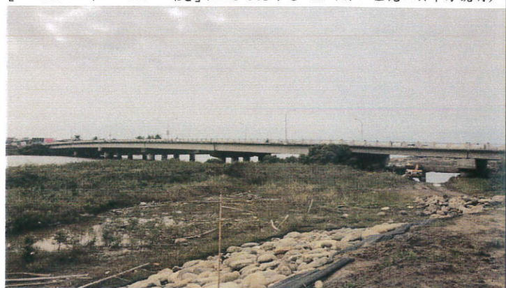
日期：2022/2/24施工廠商拍攝 說明：已施工，沒有擾動影響。
