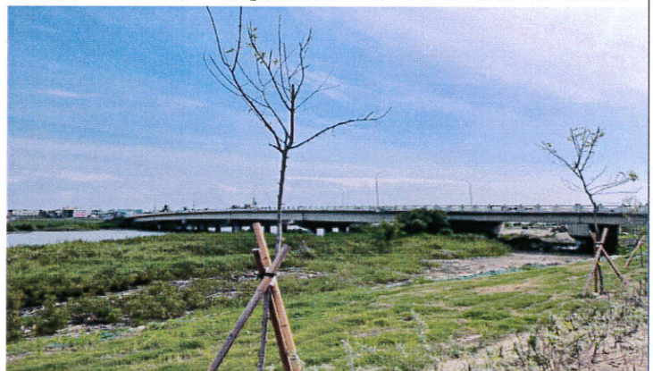
日期：2022/8/31施工廠商拍攝 說明：已施工，沒有擾動影響。
