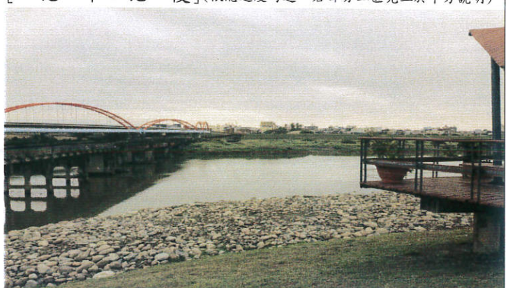
日期：2022/2/24施工廠商拍攝 說明：岸邊施作，溪水濁度控制良好。
