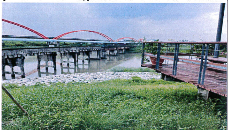
日期：2022/8/31施工廠商拍攝 說明：岸邊施作，溪水濁度控制良好。
