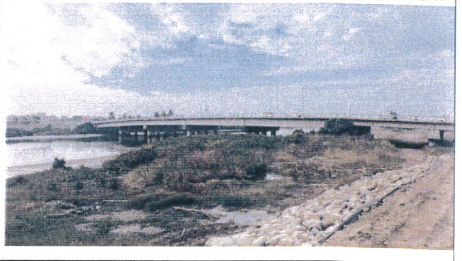
日期：2021/11/30施工廠商拍攝 說明：已施工，沒有擾動影響。
